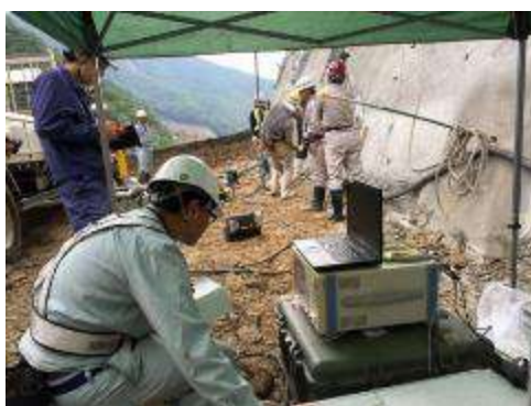
図 2.1-3 計測状況の例
